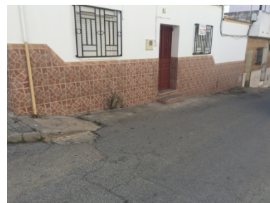
03. Imagen de acerado y acceso vivienda
