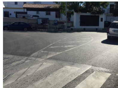
15. Imagen de la intersección de la calle con la avenida Blas Infante
