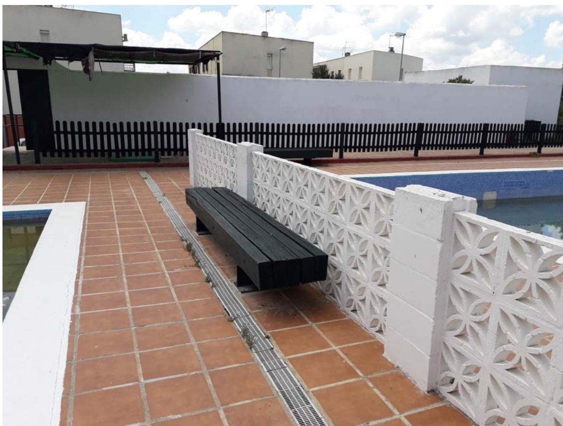
Zona de piscina de rebosadero. Vallado, pavimento y revestimiento de vaso.
